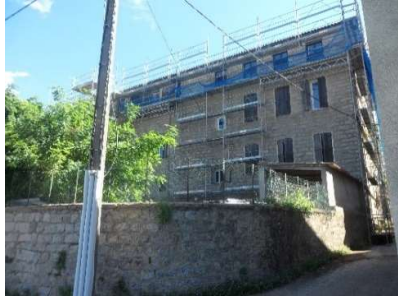
Rénovation du bâtiment communal (2022)
