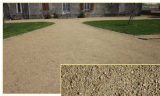
Stabilisé mécaniquement « CHAPE »
