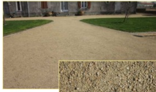
Stabilisé mécaniquement « CHAPE »
