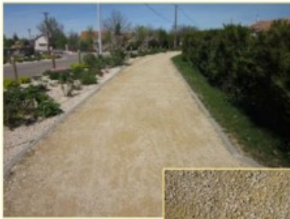
Stabilisé mécaniquement « STABILISÉ CALCAIRE »
