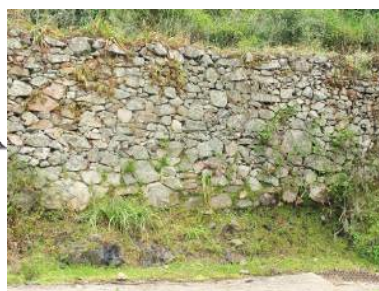
Exemple de murs de soutènement
