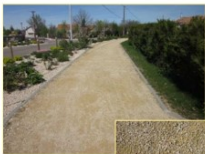
Stabilisé mécaniquement « STABILISÉ CALCAIRE »
