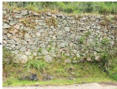
Exemple de murs de soutènement
