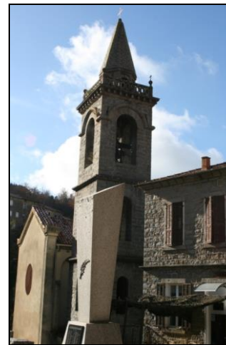
L'Église de la Sainte-Trinité Photo : Diagnostic du PLU de 2019
