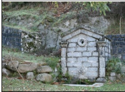
Photo 2 : Vue de la fontaine de Centuliri
