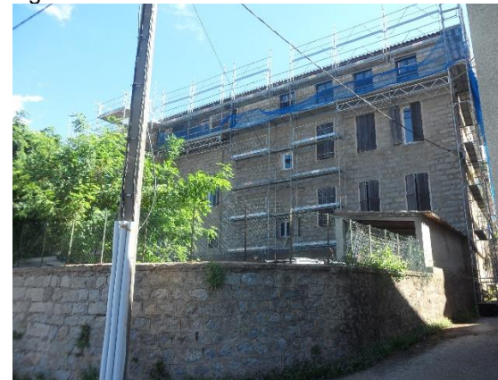
Bâtiment communal en travaux
