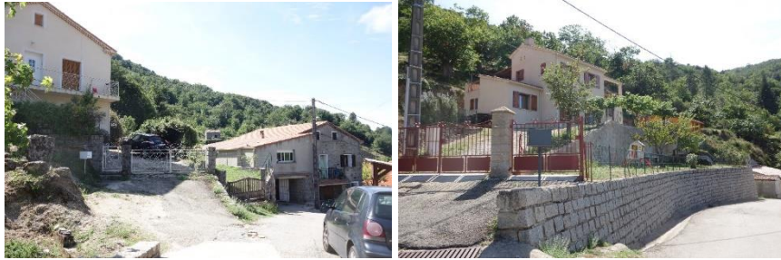
A Ricineddu, le bâti ancien s'échelonne dans la pente. Des maisons anciennes sont rénovées d'autres restent inhabitées.
