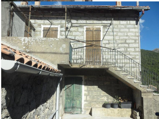
Installation sur les façades visibles Ajouts extérieurs
